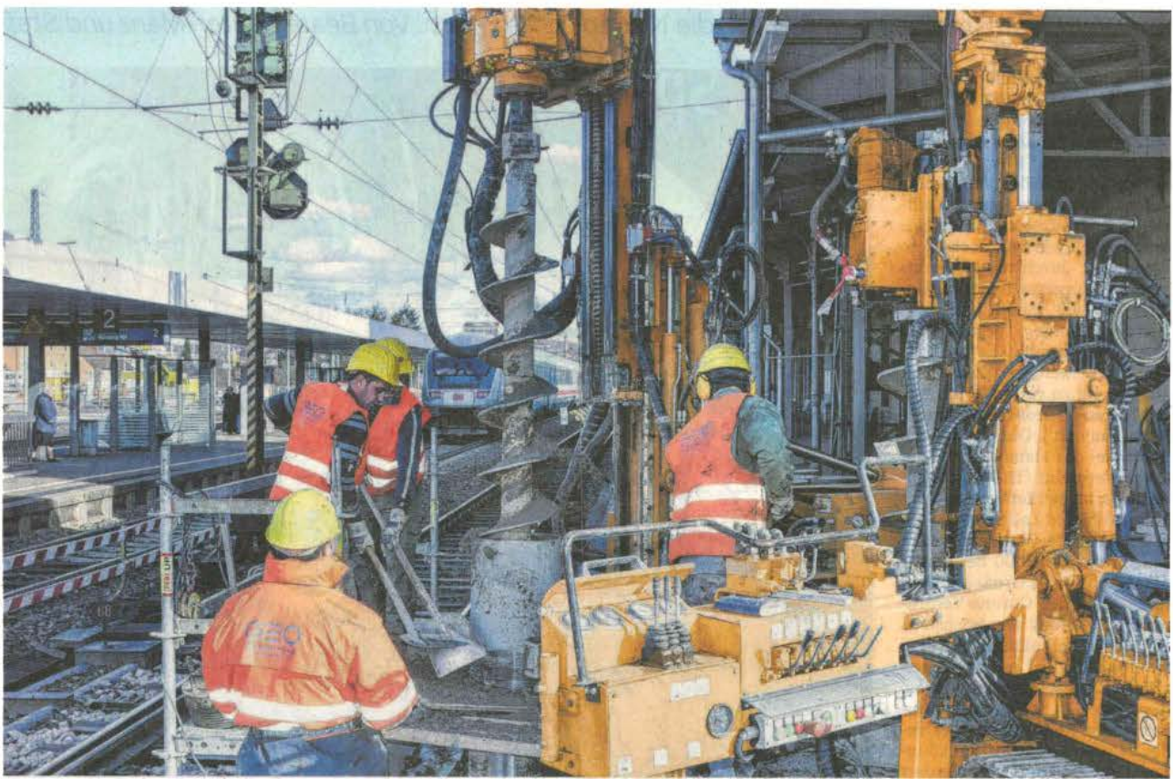
Tiefe Löcher bohren bei laufendem Bahnbetrieb – dafür braucht man Spezialisten.
