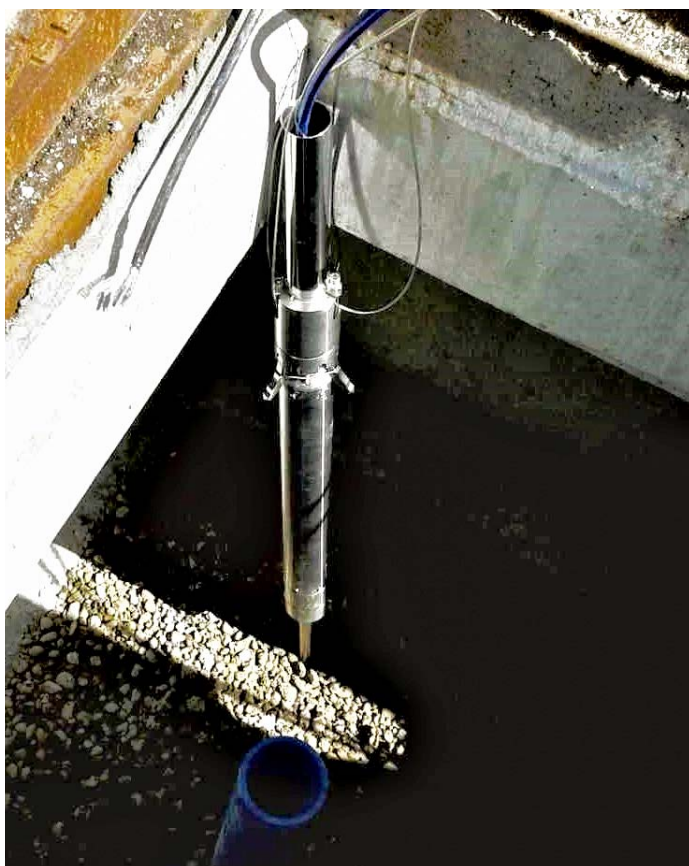
Abb. 3: Das Bohrlochseismometer ist etwa 1,2 m lang und wird an einem Kabel in die Bohrung (blaues Rohrende unten im Bild) abgelassen.
