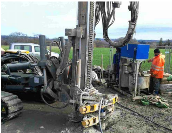
Abb.2: Eine Sonde wird in das Bohrloch abgelassen. Die Verrohrung hat einen Durchmesser von 8 cm.
